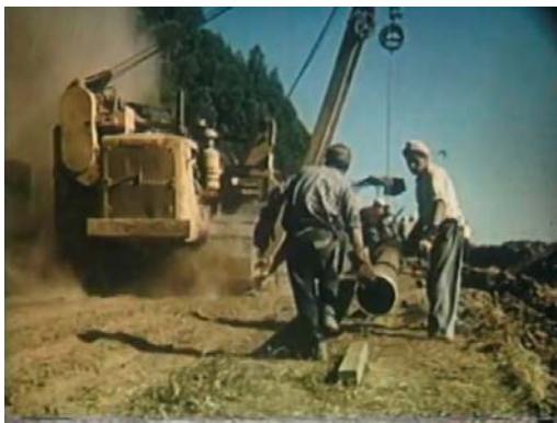
Figura 7: Obreros instalando un sistema de cañerías
